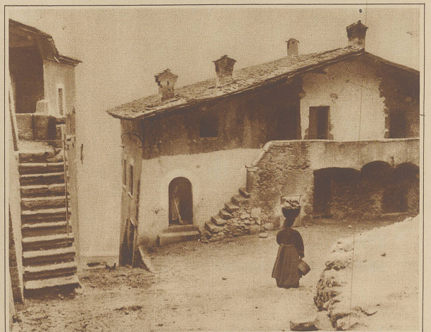
Ein Wohnhaus in Scanno. Der Baustiel hat gewisse Ähnlichkeiten mit alten Bänderhäusern
