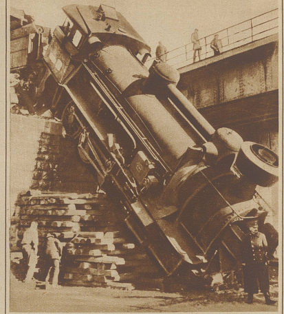
Eisenbahnunglück bei Wien. Infolge falscher Weichenstellung stürzte ein Zug in die Gunoldstraße hinab. Neun Beamte wurden schwer verletzt
