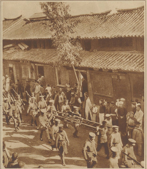
Chinesische Maschinengewehr-Abteilung. Das Maschinengewehr wird auf zwei Bambusstäben getragen
