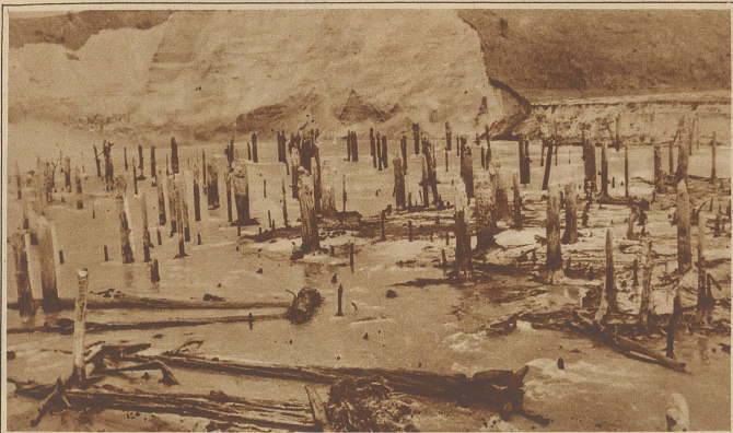
Ein «prähistorischer Wald» wurde bei Arapuni (Neuseeland) entdeckt, als man sich beim Bau eines Elektrizitätswerkes genötigt sah, einen Flußlauf zu verlegen. Das Wasser grub sich in wenigen Tagen ein neues Bett, in welchem in fünf Meter Tiefe diese Baumstämme eines Jahrtausende alten Waldes gefunden wurden, der wohl seinerzeit bei einem Vulkanausbruch zugedeckt und nun auf diese seltsame Weise wieder ans Tageslicht gefördert worden ist
