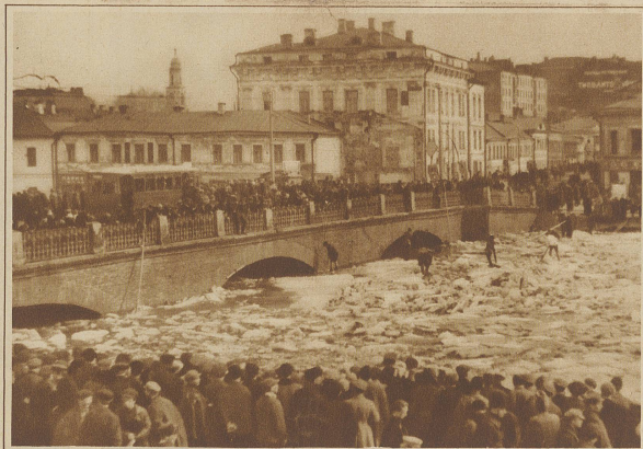
Moskau hat einen äußerst strengen Winter erlebt. Die meisten Kanäle waren meterdick zugefroren, so daß das nun eingetretene Tauwetter einen gefährlichen Eingang der Flüsse bevrcht. Das Bild zeigt Arbeiter an der Arbeit vor einer gefährdeten Brücke
