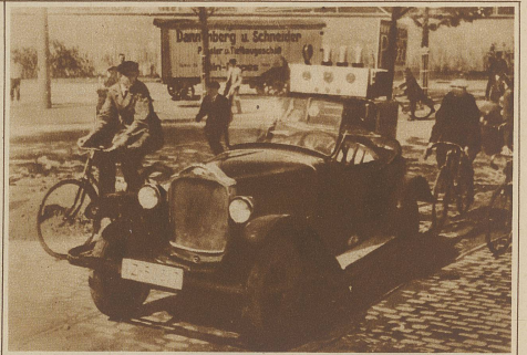
In den Straßen Kölns erregte dieser Tage ein führerloses Auto großes Aufsehen. Durch elektrische Fernsteuerung gelang es, den Wagen in verschiedenen Fahrgeschwindigkeiten gefahrlos durch den Straßenverkehr zu steuern.
