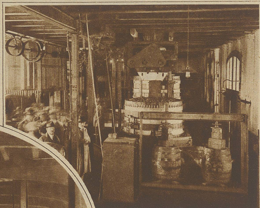
Mosterei Egnach. Vor den Pressen steht eine Fabreinigungsmaschine
