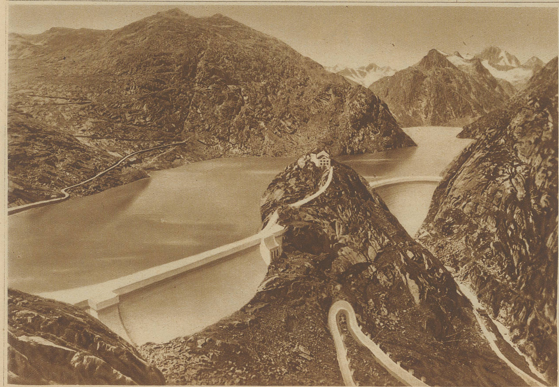
Zum Bau der 380 m langen Gelmersperre, die den Spiegel des Gelmerees um 30 m erhöhen und damit dreizehn Millionen Kubikmeter Stauroum schaffen wird, sind die Geleise der Materialtransportbahn auf die Eisengerüste gelegt worden, die mit einbetoniert werden
