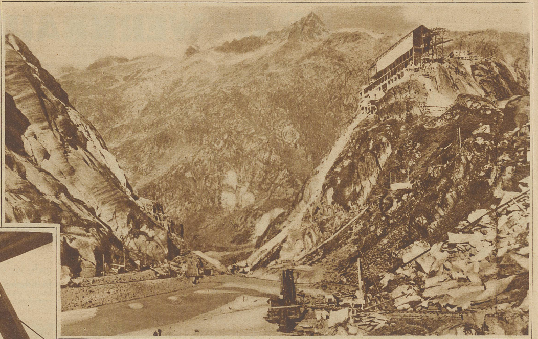
Blick durch die Spitalamm hinab, die durch eine 115 m hohe, an der Sohle 68 m, auf der Krone 4 m dicke Sperrmauer von 340,000 Kubikmeter Masse verriegelt wird
