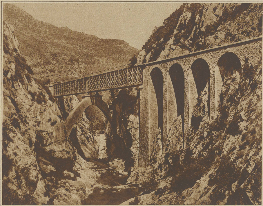
Brücke über die Bévéra. Das Bett des Wildbaches ist so eng, daß es die Errichtung eines Zentralpfeilers nicht erlaubte. Die steinernen Bogen wurden daher durch eine Metallkonstruktion verlängert, die sich auf den Scheitel eines die beiden Wände der Schlucht verbindenden gemauerten Spitzbogens stützt
