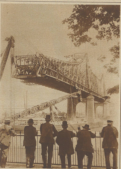
Die neue Blackwells-Island-Brücke im Staate New York im Bau
