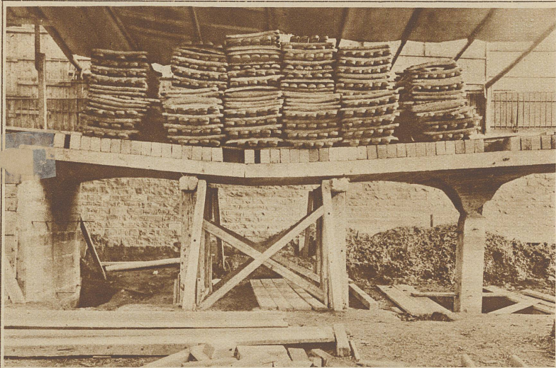
Wirkung der Belastung auf die Probekonstruktion
