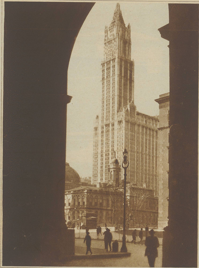
Das Woolworthgebäude, durch die Arkaden der Stadthalle gesehen
