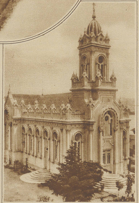
Eine eiserne Kirche. Die bulgarische Kirche «Sveti Stefan» in Konstantinopel ist ganz aus Eisen erbaut. Das einzigartige Bauwerk wurde vor 35 Jahren von einem österreichischen Architekten entworfen. Alle Teile wurden in Wien hergestellt und in einigen tausend Kisten verpackt nach Konstantinopel gesandt. Auf dem kleinen Friedhof neben der Kirche befindet sich das Grab des Bischofs Ilarion Mariopolski, des Vorkämpfers für die Befreiung Mazedoniens
