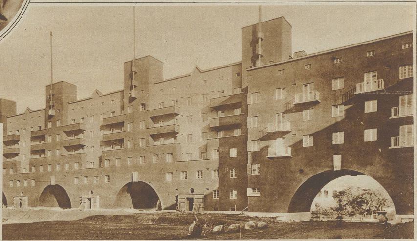
Der neue Baustil der von der Stadt Wien erbauten Mietsh user
