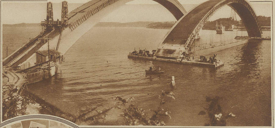
Die größte Bogenbrücke der Welt (1200 Meter lang) wird zur Zeit in Frankreich von Brest nach Plougastel gebaut. Der Unterbau besteht aus drei Bogen, die auf zwei Pfeilern im Meere ruhen. Die Aufnahme zeigt den Antransport des Leer- gerüstes für den Mittelbogen; der erste Bogen links ist schon betoniert
