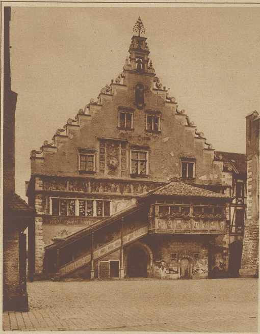
Durch einen Brand im Sitzungssaale des alten Rathauses in Lindau ist das prächtige historische Gebäude stark beschädigt worden. Viel kulturhistorisch wertvolles Mobiliar, sowie wertvolle Gemälde und Altertümer wurden vom Feuer völlig zerstört. Dagegen gelang es, die Holzdecke und die städtische Sammlung zu retten. Erbaut wurde das Rathaus in den Jahren 1422-36
