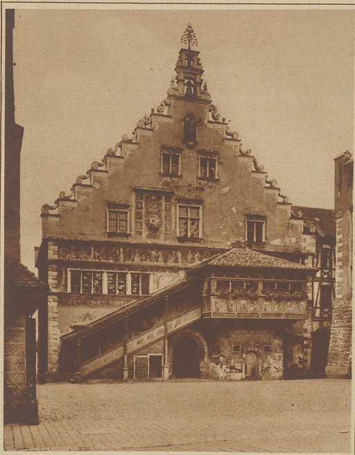
Durch einen Brand im Sitzungssaale des alten Rathauses in Lindau ist das prächtige historische Gebäude stark beschädigt worden. Viel kulturhistorisch wertvolles Mobiliar, sowie wertvolle Gemälde und Altertümer wurden vom Feuer völlig zerstört. Dagegen gelang es, die Holzdecke und die städtische Sammlung zu retten. Erbaut wurde das Rathaus in den Jahren 1422-36
