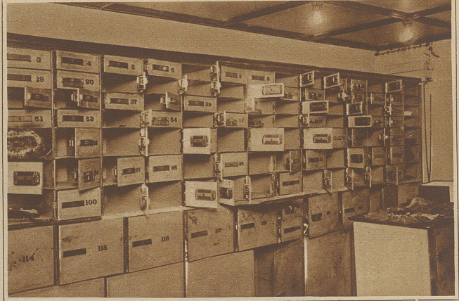
Ein Teil der ausgeräumten Tresorfächer. Links im Bilde sind noch die Spuren eines Knallgasgebläses sichtbar, das zum Aufschneiden der Stahlplatten diente
