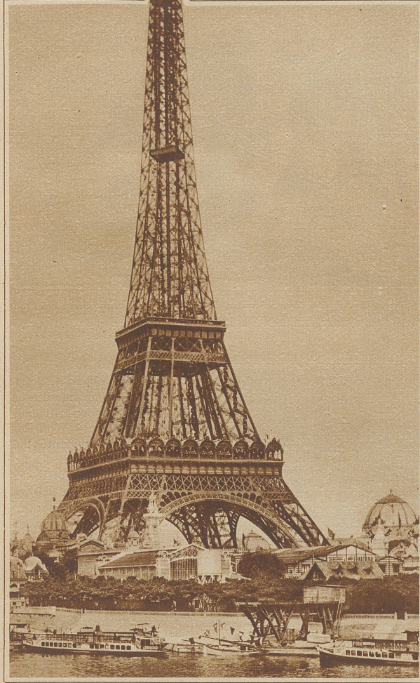
Eiffelturm, erbaut in den Jahren 1887-89 vom Pariser Ingenieur Gustave Eiffel. Höhe 300 m. Der Unterbau des Turmes ruht auf Betonklöben von 676 m 2 Grundfläche. Der Turm wiegt 9 Millionen kg. Die erste Plattform liegt 57,63 m, die zweite 115,73 m über dem Erdboden. Bis zur Spitze führen 1792 Stufen
