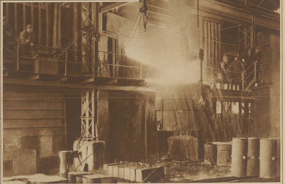
Gießen des Stahls
