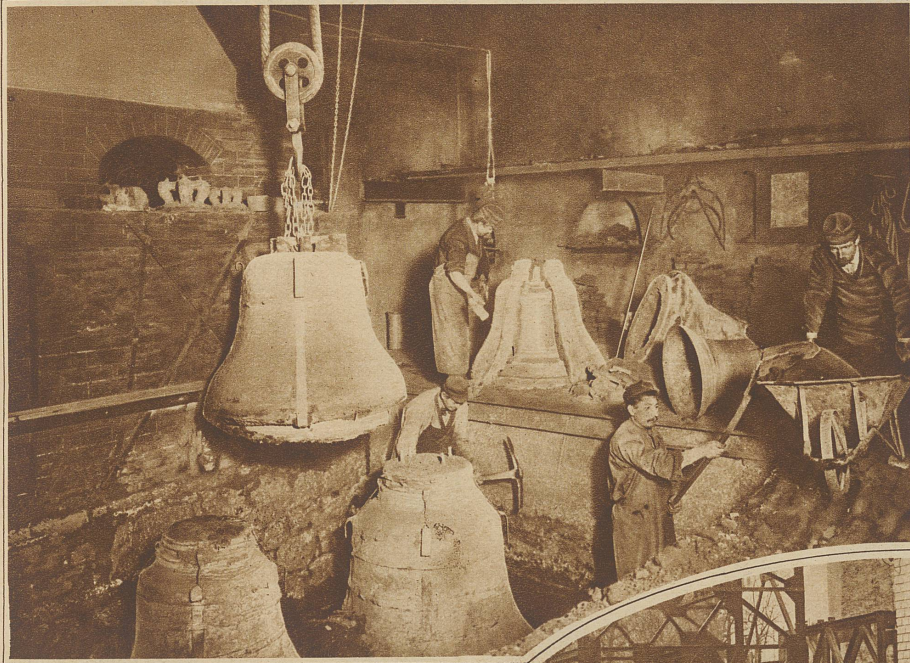
Ausheben der Glocken aus der Gußgrube
