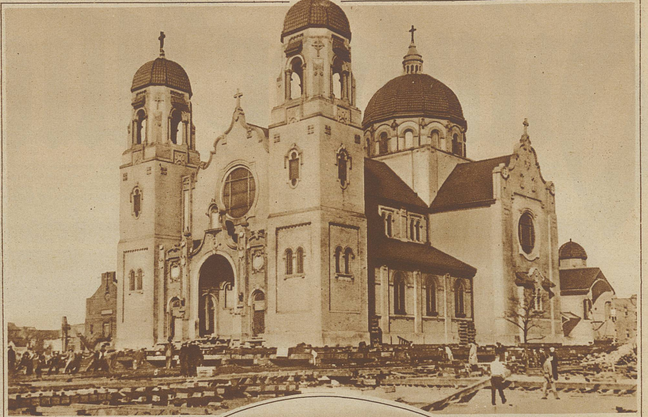
Eine Kirche wird versetzt. Man hat ja auch bei uns schon wiederholte ganze Häuser von ihrem Standort weggeschoben und in mehr oder weniger gewaltiges Objekt, wie es die Notre Dame-Kirche von Chicago darstellt, die letzter Tage von der einen Seite der Straße auf die andere «gerollt» wurde, hat man sich doch noch nicht gewagt
