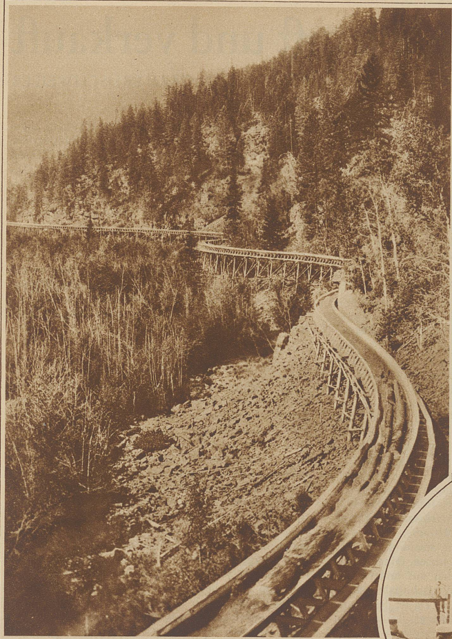
Eigenartige Holztransportbahnen werden in den riesigen Wäldern von British Columbia gebaut. Da es sich in diesen unwegsamen Gebieten Kanadas nicht lohnen würde, Straßen oder gar eine Eisenbahn anzulegen, verfiel man auf die Idee, große Schwemmkänäle zu errichten, durch welche die in den oberen Regionen gefällten Baumstämme viele Kilometer weit zur Verarbeitung in die Papierfabriken transportiert werden
