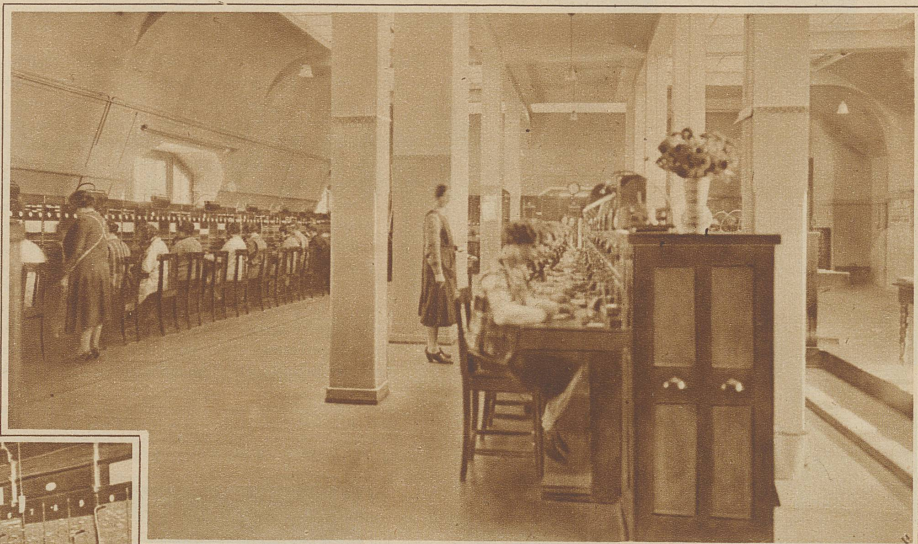
Der Apparatsaal im Telephongebäude Selnau. — Es arbeiten darin ständig 50-60 Telephonistinnen
