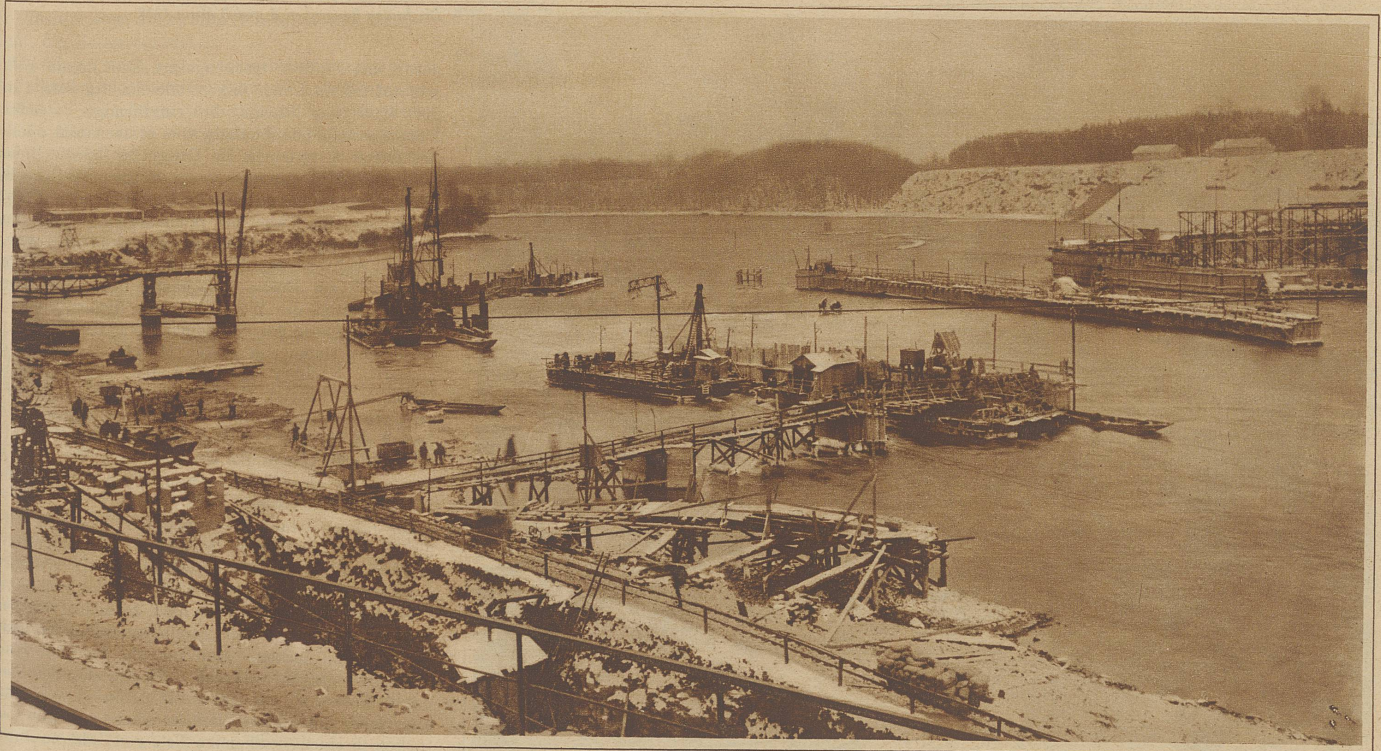
Während der ersten Bauperiode im Winter 1927. Die schwimmenden Bohr-Batterien täuschen das Bild eines Kriegshafens vor
