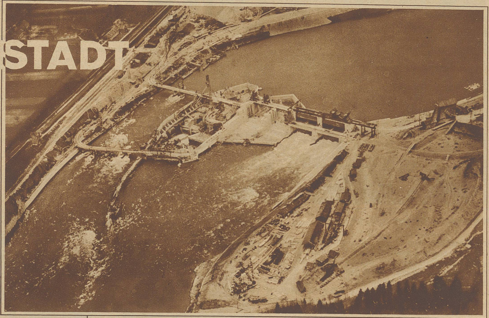
Flugaufnahme des im Bau befindlichen Werkes
