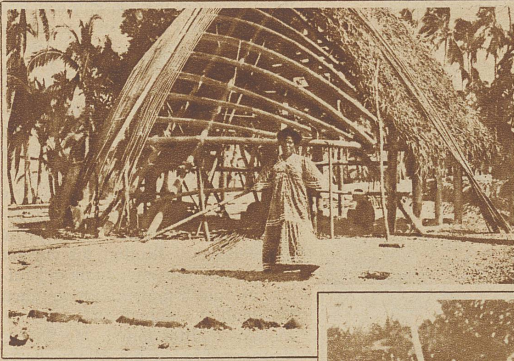
Frau Kalila, die siebzehnte Gattin eines Häuptlings, in einem Kleide aus bedrucktem Kattun. Im Hintergrund ein samoanisches Haus im Bau
