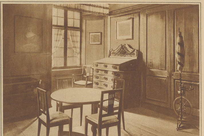
Neuinstallierte, ehemalige Audienztube des Landvogts, nach 1760 umgebaut
