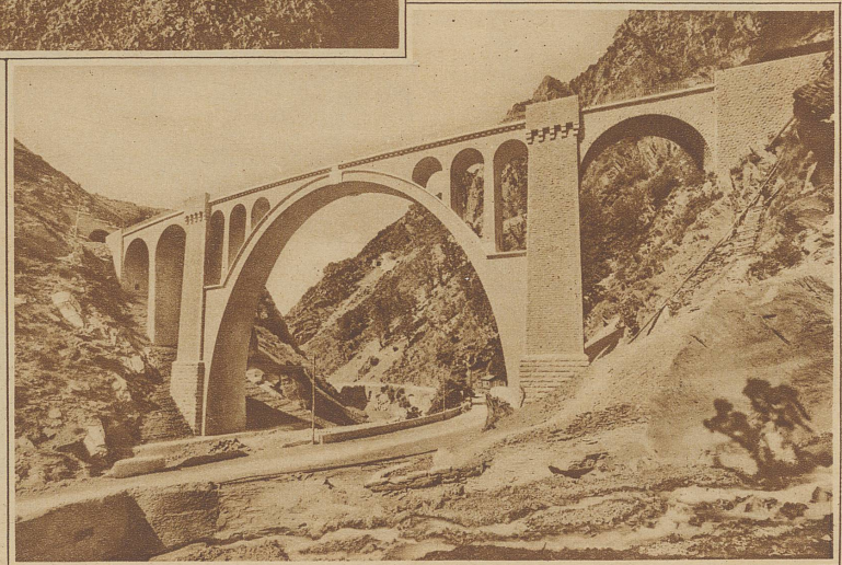
Der Viadukt von Scarauoussi auf der neuen Eisenbahnlinie Nizza-Cuneo
