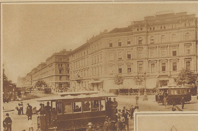
Die erste elektrische Straßenbahn mit unterirdischer Stromzuführung wurde vor 40 Jahren in Budapest in Betrieb genommen. Die Fahrleitung befindet sich im Schlitzkanal der Schienen.
