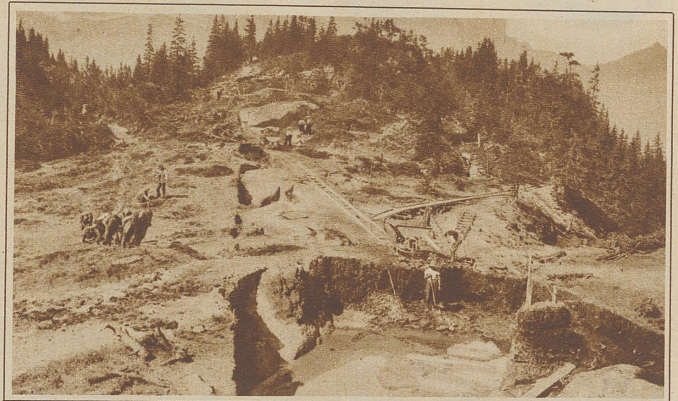
Fundierungsarbeiten für die östliche Staumauer auf «Garichte» (Mettmen)
