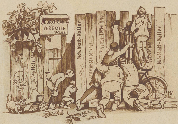
Der Bau der Kornhausbrücke erregt sich des lebhaften Interesses der gesamten Bevölkerung
