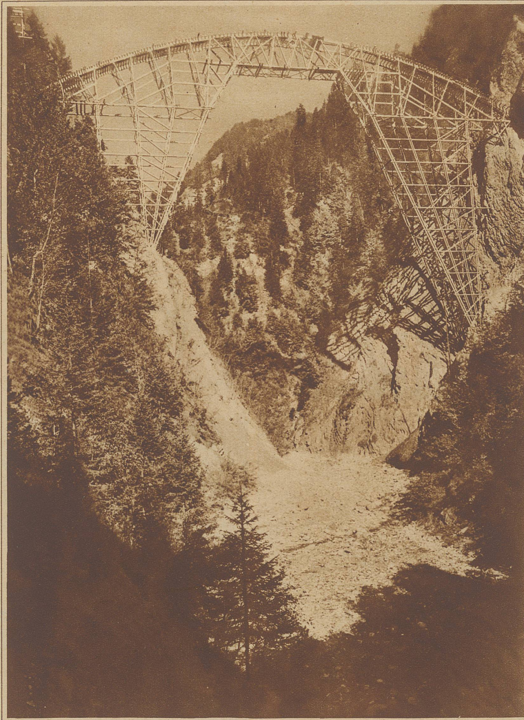
Das Gerüst der Salginabrücke, die Schiers mit dem Bergdörfchen Schuders verbindet. Sie ist ein Beweis dafür, wie man sich in Graubünden bemüht, der Entvölkerung der Gebirgstäler entgegenzuarbeiten. Erbauerin ist die bekannte bündnerische Brückenbaufirma Coray
