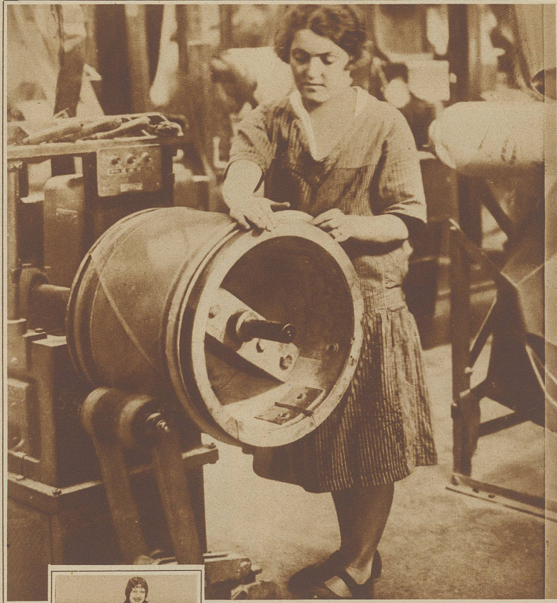
Verheiratete Frau als Schwerarbeiterin. Konfektion eines Autoreifens auf die Aufbaumaschine
