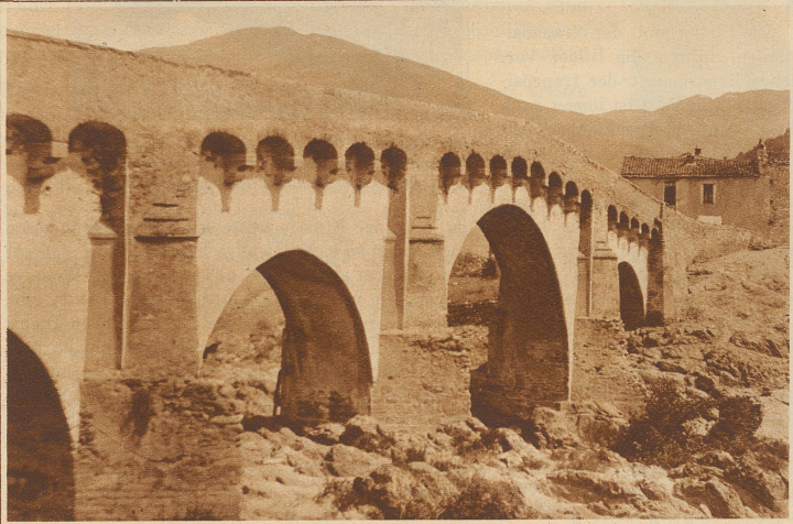
Ponte Leccia, die schönste Brücke Korsikas
