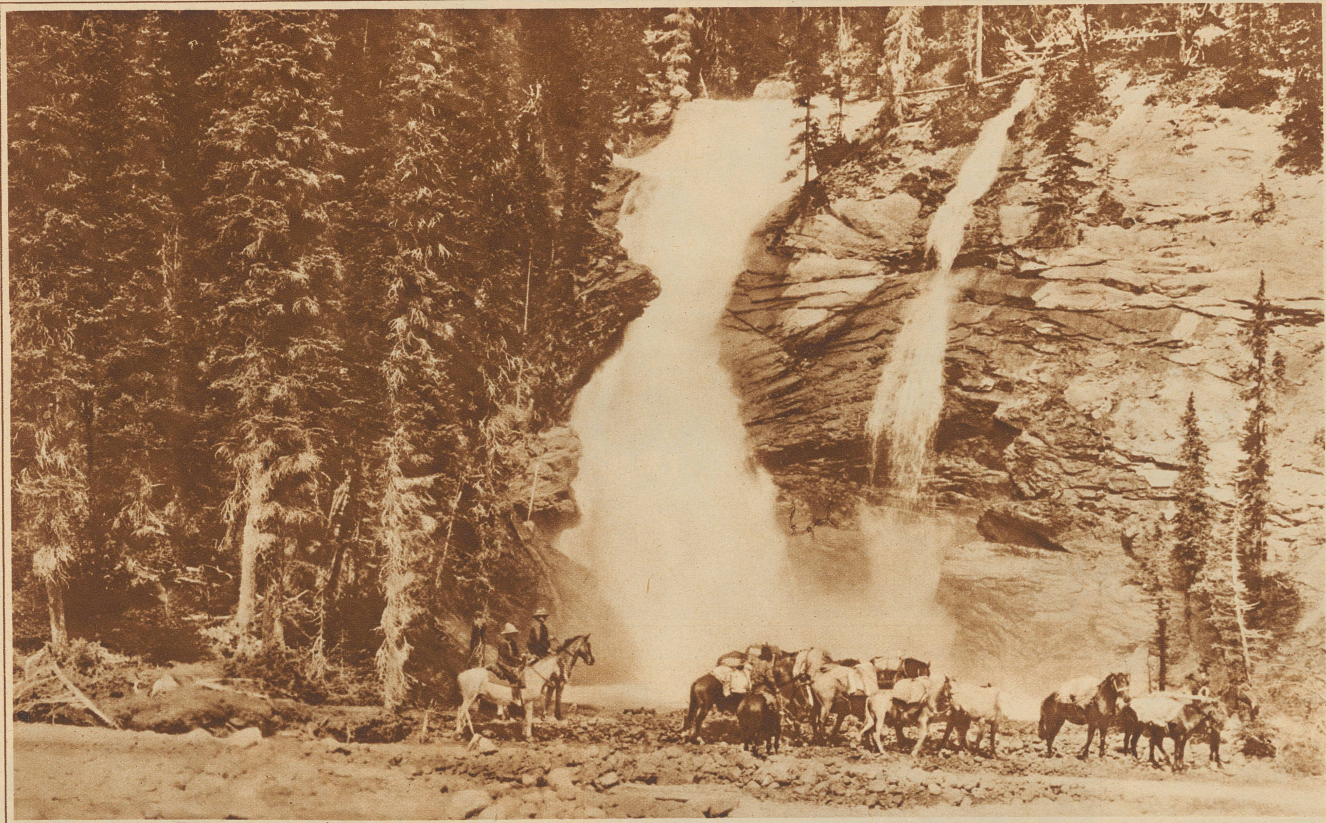
Rast an den Castleguardfällen
