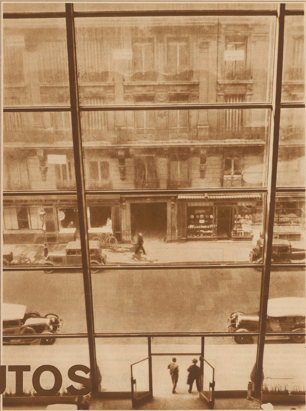
Blick durch die 5 stöckige Glaswand eines Pariser «Warenhauses» für Autos. Die Wand erscheint ganz schwebend, trotzdem das Eisengerippe der ungeheuren Glasflächen 19 000 kg wiegt
