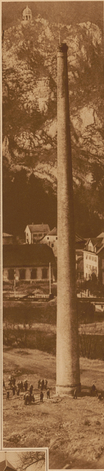
Vor der Sprengung. Die kleinen Menschen am Fuß des Kamins sind ein willkommener Maßstab für die Größenverhältnisse
