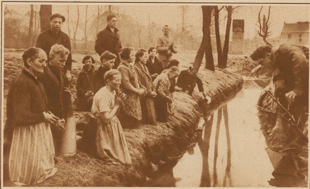
Das Bachwaschen, ein alter oberschlesischer Karfreitagsbrauch, der mit einem andächtigen Gebet abgeschlossen wird
