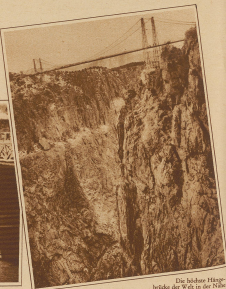
Die höchste Hängebrücke der Welt in der Nähe von Cañon City in Colorado (Vereinigte Staaten). Die Spannweite ist 100 m und die Brücke 270 m. Die Spannweite von Träger zu Träger beträgt 270 m, die ganze Länge der Brücke 300 m
