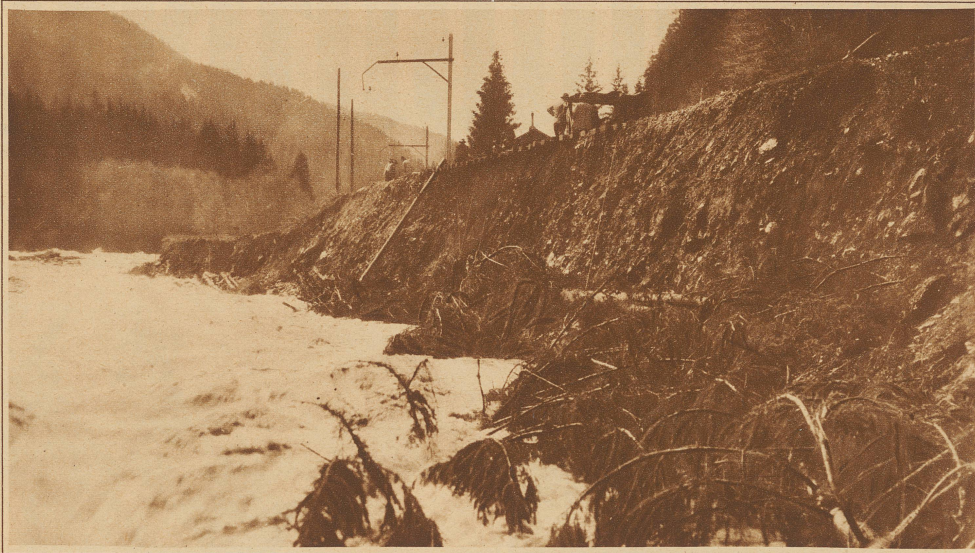
Hochwasser der Simme bei Grubenwald (Berner Oberland). Der Damm ist bis unter den Bahnkörper weggerissen (Phot. R. Wenger)
