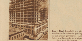
Am 1. Mai. Innerhalb von vier Wochen ist das Gebäude gewohnt in die Höhe gewachsen. Dem Stahl- und Betonarbeiten folgen jetzt auch die Mauer.
