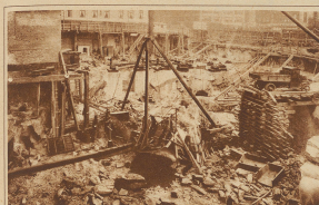
Am 3. Januar. Mit Dampfschiffen, Derricks und komplizierten Hebern haben die Arbeiter ihren Weg bis 50 Fuß unter dem Straßenniveau in die Granitfelsen von Manhattan gebohrt. Es ist bekannt, daß Manhattan Island eine Felsinsel ist, und daß lediglich der Felsenuntergrund den Bau der riesigen Wolkenkratzer mit 60 und mehr Stockwerken ermöglichte.
