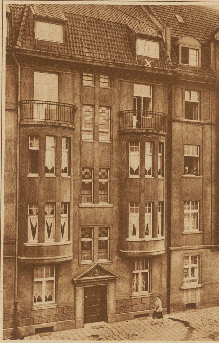
Die Wohnung des Mörders im Dachstock des Hauses Mettmannerstr. 71
