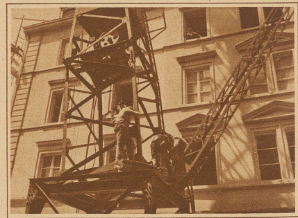
Die Füße des aufgestellten Eisenkranes werden am Eisengestell festgemacht
