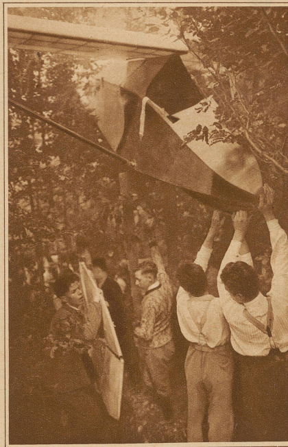
Ein Segelflugzeug ist über dem Wald abgestürzt. Nur mit großer Behutsamkeit gelingt es, das Flugzeug zu demontieren, ohne daß es weiter Schaden nimmt
