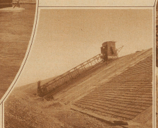
An dieser Stelle hat der Kanal eine Tiefe von 12 m und eine Breite von 150 m. Die Staumauer wurde mit einer Spreitmaschine leicht betont
