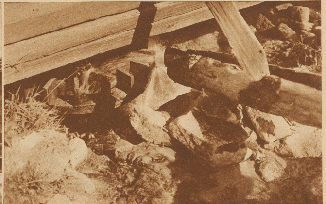
Turbinenrad einer Mühle im Wallis
