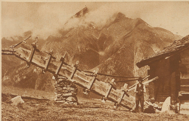
Hölzerne Druckleitung zu einer Walliser Getreidemühle
