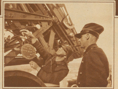
Ein Hebeldruck, ein Blick auf die Skala, und die mächtige Steigleiter erhebt sich mit Motorkraft innert weniger Sekunden zur nötigen Höhe. Rechts der Chef der Zürcher Brandwache
