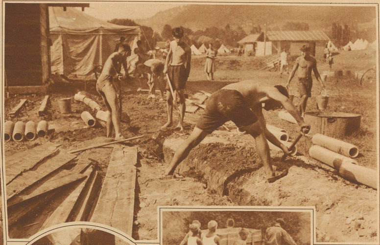
Das Röhrenlegen zur Beseitigung des Abwaschwassers will gelernt sein und braucht kräftige Arme
