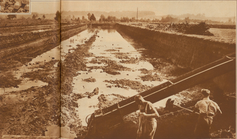
Der frühgegrabene Torf wird abgedreht und zum Anstrocknen ausgebreitet.
