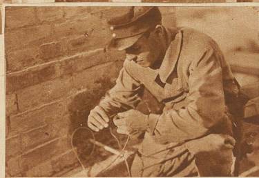
Der Mineur hat ein Loch in den Fuß des Kamins gebohrt und eine Sprengpatrone mit elektrischer Zündung sorgsam hineingelegt. Nachdem das Sprengloch zugemauert wurde, verbindet er die Zündung mit einer elektrischen Leitung.
