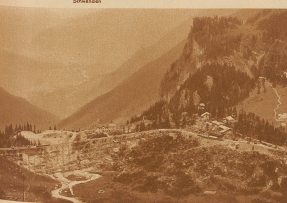
Die Staumauer auf Alp Garitzke im Bau
