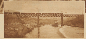
Blick auf die Baustelle von der alten blühenden Straßensbrücke aus. Umrinne oberhalb der Bahnbücke werden die Stauwehr und das Maschinenhaus errichtet. Oberhalb der Brücke (siehe im Bild) ist der Bau der Wohnkolonie für das Betriebspersonal im Gange. (Foto: S. G.)
