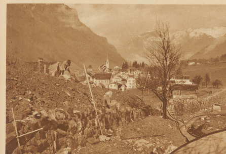
Blick von der Gefahrenzone gegen Lintthal talwärts. An der Erstellung eines Scherwalles im Vordergrund wird mit Wägen überhört gearbeitet.
